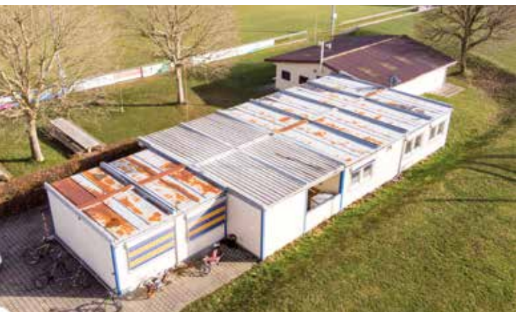
s „Hüttli“ vor dem Rückbau 2019
