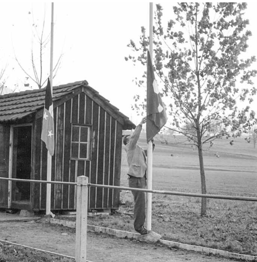
Unser erstes Materialhaus auf dem Ebnet
