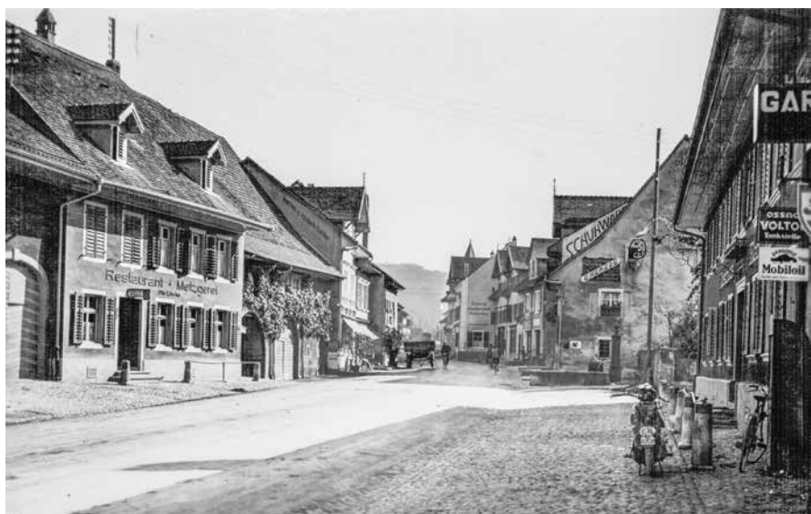
Erstes Umkleidelokal war das Restaurant- Metzgerei Rössli - ohne Dusche! Hier ein Bild aus dem Jahr 1934.
