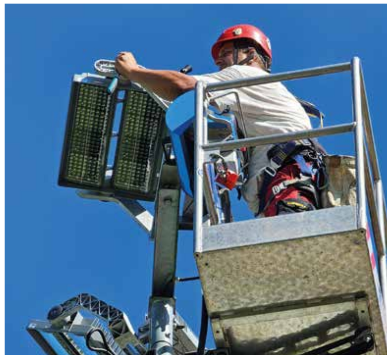
Montage der neuen LED Beleuchtung
