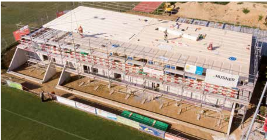
Das neue Klubhaus im Rohbau
