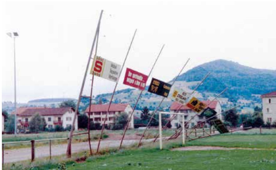
Der Sturm hatte Schäden am Ballfänger und einigen Bäumen hinterlassen
