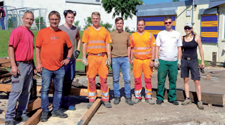
Das Abbruchteam hat begonnen, das alte Clubhaus zu demontieren
