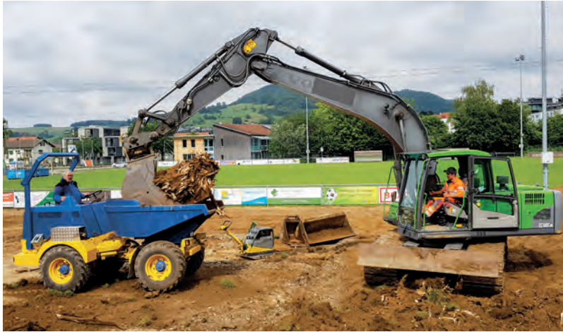
Der Humus wird depo- niert und die Fundamente ausgehoben
