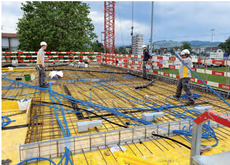
Die Decke ist bald bereit zum Betonieren so dass die Elektrokabel verlegt werden können
