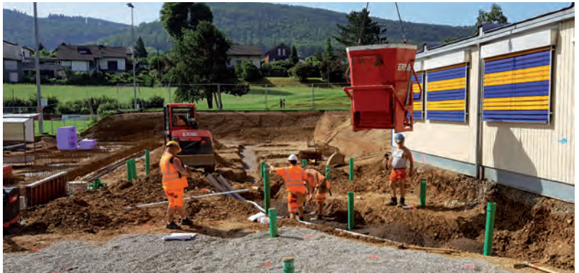
Die ersten Fundamente werden beto- niert
