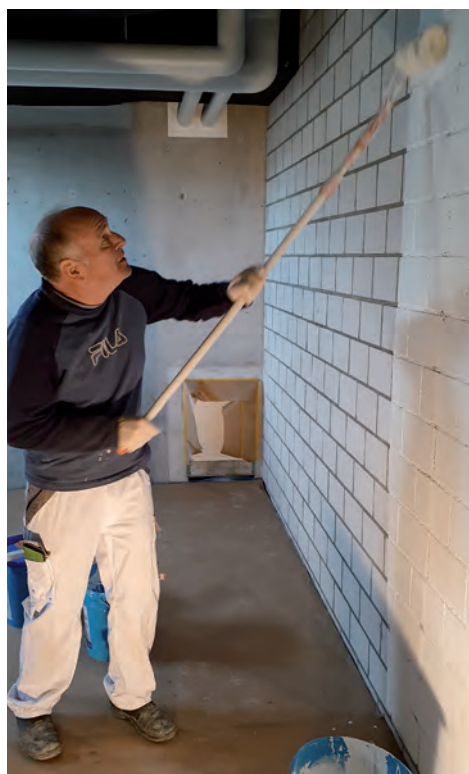
René Arnet, ehemaliger Torhüter, beim streichen der Wände.
