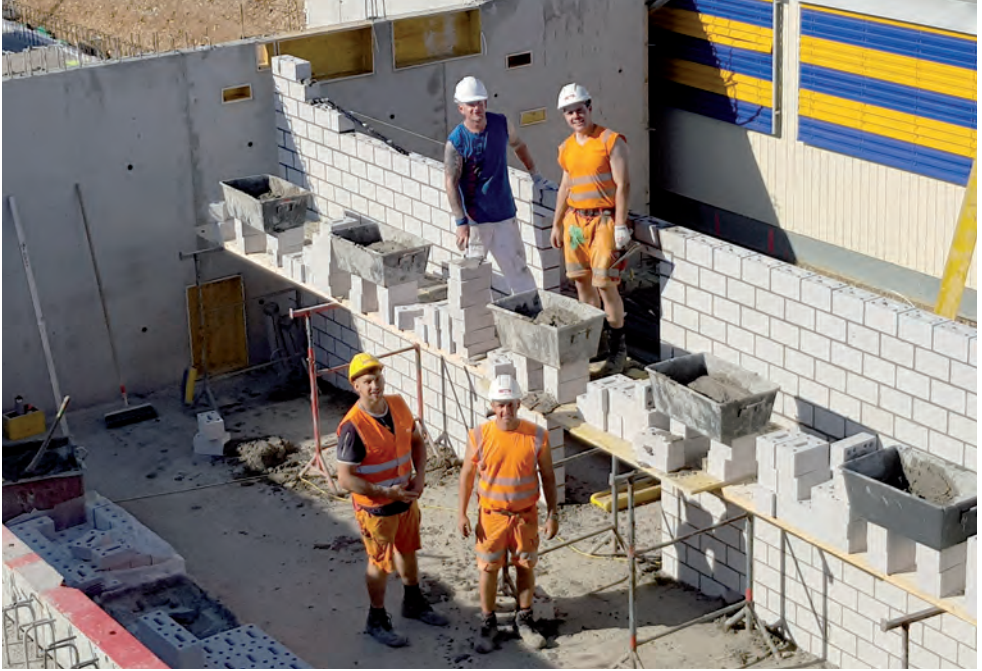
Die Mauern im Untergeschoss werden hochgezogen
