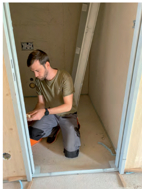
fachgerecht werden die Türen montiert.
