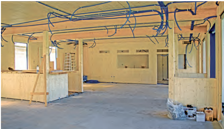
Der Innenausbau im Obergeschoss hat begonnen.
