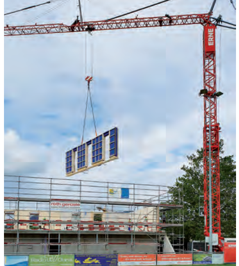
Die vorfabrizierten Elemente des Obergeschosses werden montiert
