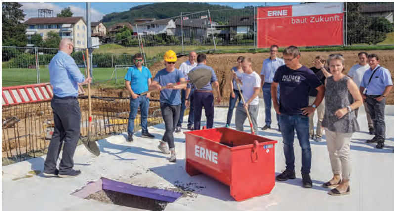
Feierlich wird die Grund- steinlegung zelebriert
