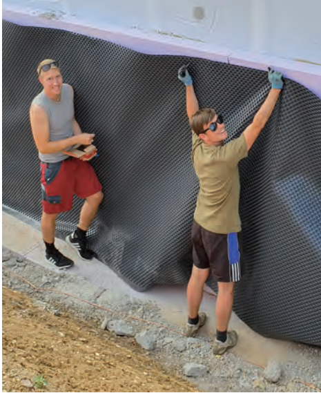
Schutzfolie wird montiert
